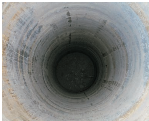
Foro di perforazione Drilling hole
