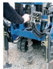
Echantillonnages par forage Probenentnahme mit Drehbohrungen
